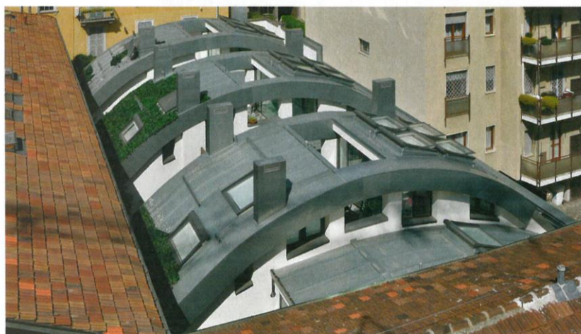
Sopra: la copertura a botte che caratterizza l'intervento di ristrutturazione dell'ex garage.
