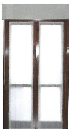
Un esempio di infisso con cassonetto dalle performance termiche e acustiche scarse
