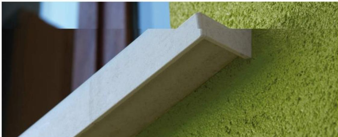
Due nuove soluzioni per completare la riqualificazione energetica del foro finestra. **Cover App** di **Roverplastik** è composta dal termobancale di polistirene estruso e di gres porcellanato, da applicare sul davanzale preesistente del vecchio serramento per una ristrutturazione non invasiva, e dal bancalino di gres porcellanato da abbinare al monoblocco RoverBlok, per una finitura elegante e ottimale.
