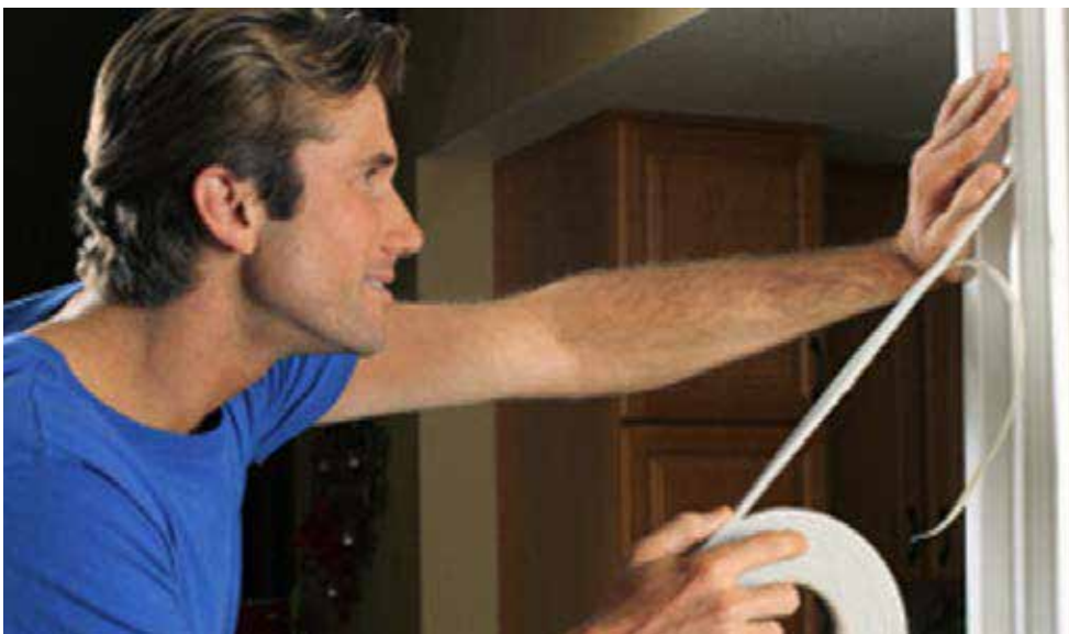
Fig 2. Inserimento guarnizioni
